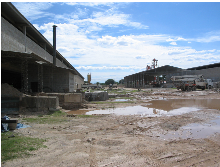
Foto 3: En esta foto se puede ver un plano general de la planta de CONCRETEC, a la izquierda podemos ver la planta de pretenzados (foto 4) y al fondo las instalaciones de premoldeados y plastoform. Sería de gran ayuda cambiar el aspecto de la playa (al centro) para mejorar la imagen interna del lugar de trabajo (moobing) para los trabajadores.
