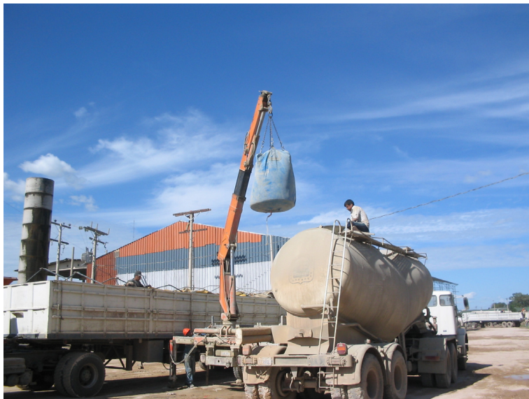
Foto 16: Adquisición de materia prima (operación tercerizada), nótese que los operadores no poseen ningún tipo de EPP.
