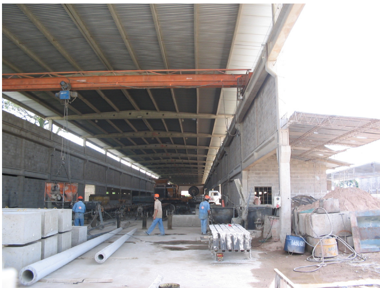
Foto 4: La nave de pretenzados, pareciera que está a medio construir, le falta señalización de salidas de emergencia, y de circulación.
