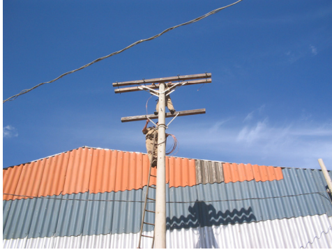
Foto 14: Trabajos en altura para expandir el tamaño de las instalaciones, en la primera el operador (empresa tercerizada) no posee arnés de protección.
