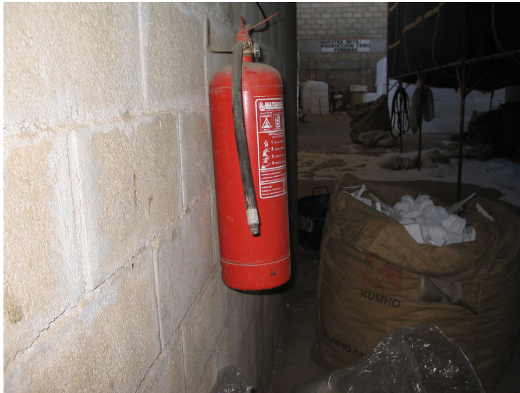
Foto 20: El único extintor que pudimos ver en toda el área productiva de la planta, el estado mantenimiento se aprecia perfectamente en la foto.
