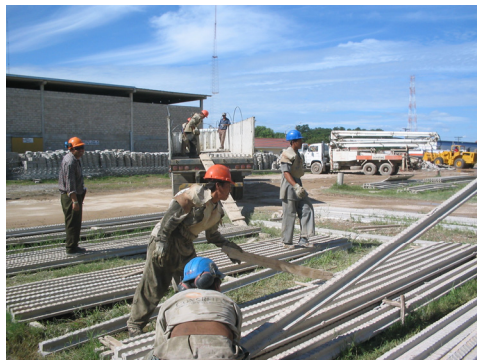
Foto 13: La playa de almacenamiento del producto terminado (Viguetas PRE-tensadas). La plataforma sobre la cual caminan los operadores para subir las viguetas es demasiado inestable y sería necesario diseñar una plataforma de entrega de material.
