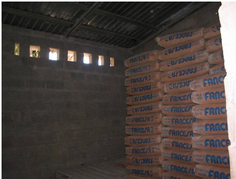
Foto 8: El recinto de almacenaje, en la foto no se puede apreciar el piso que esta impregnado con cemento en polvo que puede afectar al momento de maniobrar o en caso de viento.
