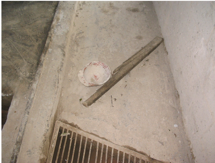
Foto 12: Equipo de protección personal usado para mezclar cemento y obstaculizando el paso en el pasillo, contradice todas las normas de seguridad industrial.
