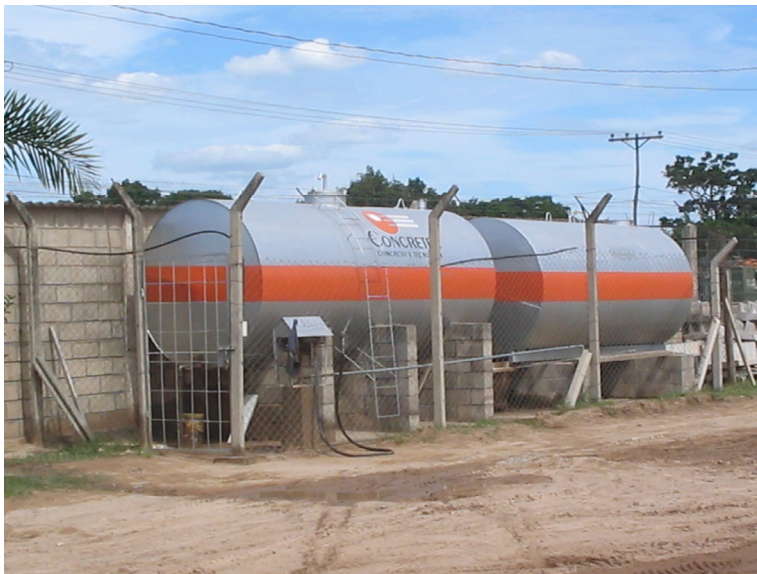
Foto 1: Aquí podemos apreciar que el tanque (de aprox. 5500 lt) de diesel no posee una protección para la radiación solar directa, tampoco mantiene normas de seguridad con respecto a depósitos de combustibles ni el material que debe rodear la instalación es el adecuado.
